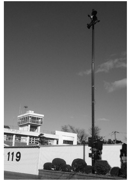
屋外拡声子局施工事例
