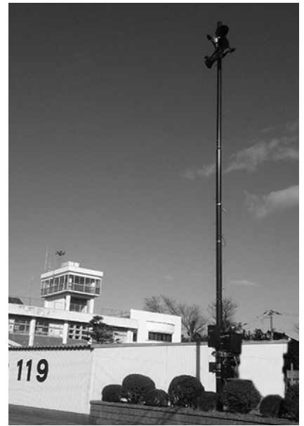
屋外拡声子局施工事例
