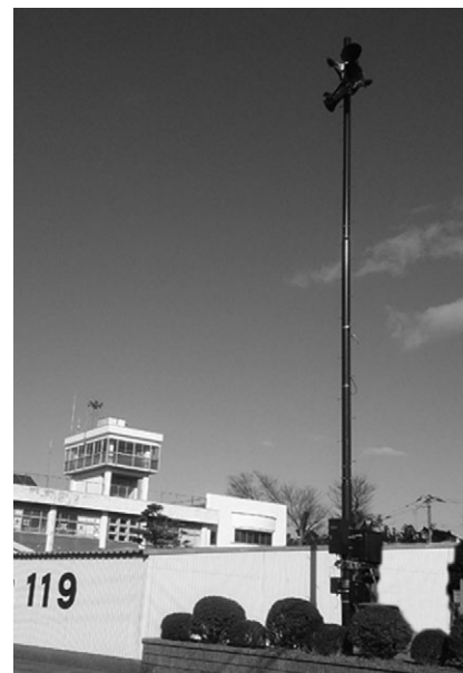
屋外拡声子局施工事例
