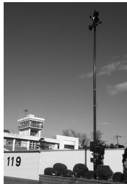
屋外拡声子局施工事例
