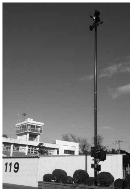
屋外拡声子局施工事例
