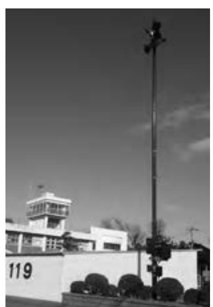
屋外拡声子局施工事例
